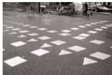
geen voorrang ondanks blokmarkering
