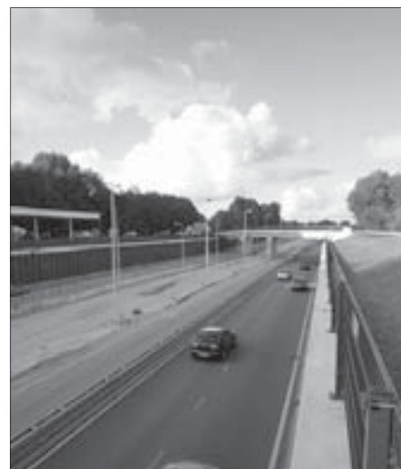
Fietsviaduct over de Leeuwarderweg
