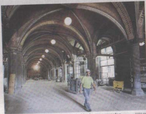
De gerenoveerde Passage zal een zeer drukke doorgang worden. FOTO: AMP
