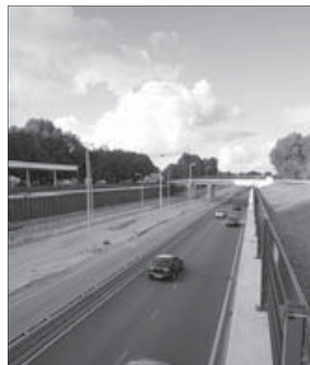
Fietsviaduct over de Leeuwarderweg
