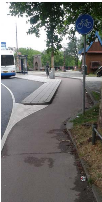
Voorbeeld 2: een slinger in het fietspad die gepaard gaat met een versmalling i.p.v. een verbreding
