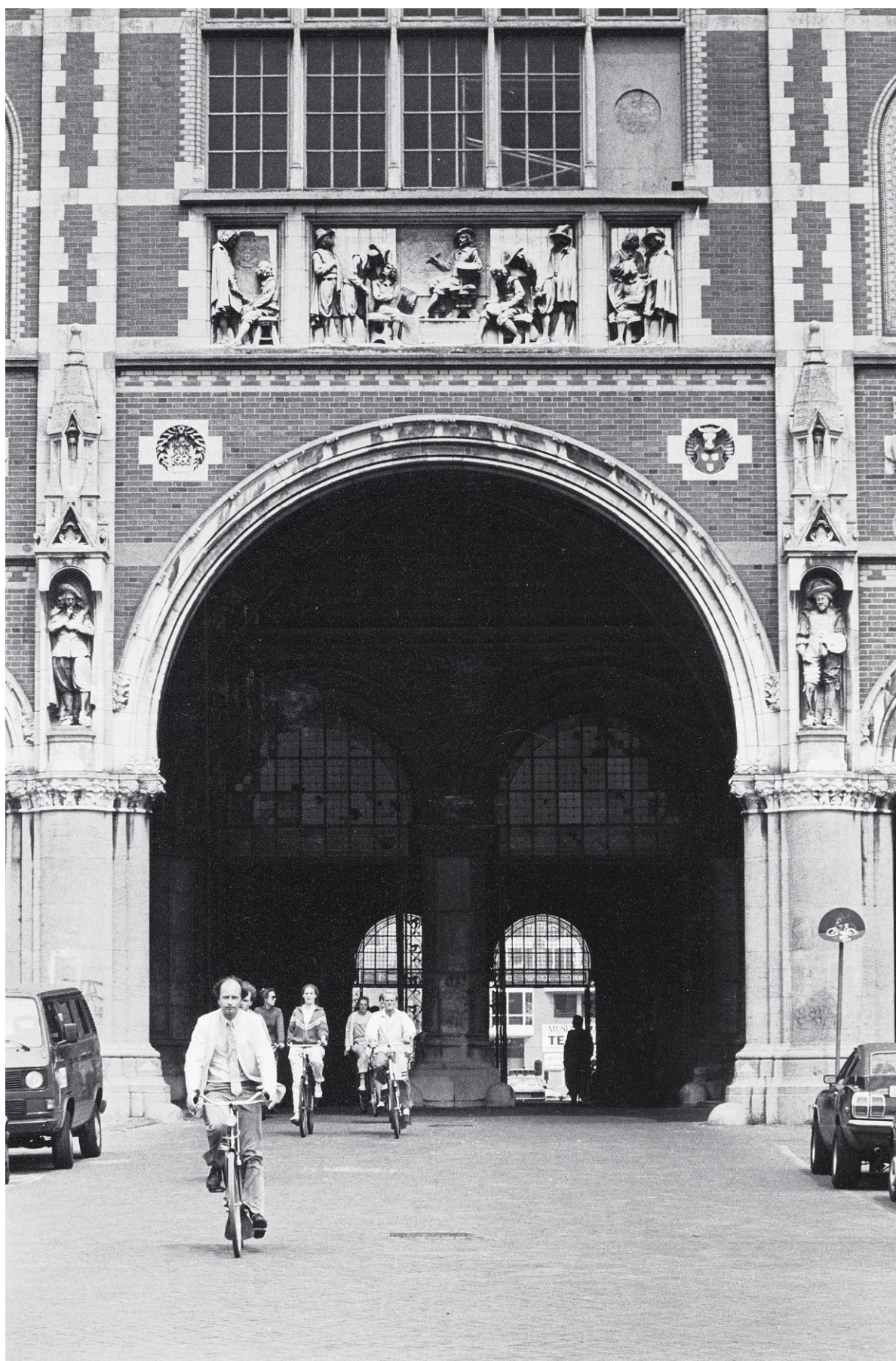
De onderdoorgang van het Rijksmuseum in 1985. Straks zit de ingang in de tunnel. Foto Vincent Mentzel
