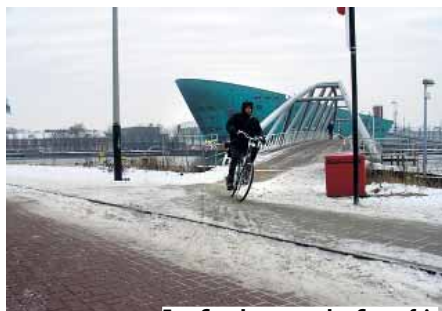
Een fietsbrug zonder fietsafrit
