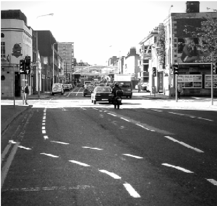
Fietsstrook die eerst uitbuigt voor bushalte, dan terugbuigt op voorsorteerstrook voor linksaf en na de kruising weer uitbuigt voor geparkeerde auto's. Dan maar liever geen fietsstrook? Foto: Archief Fietsersbond.
