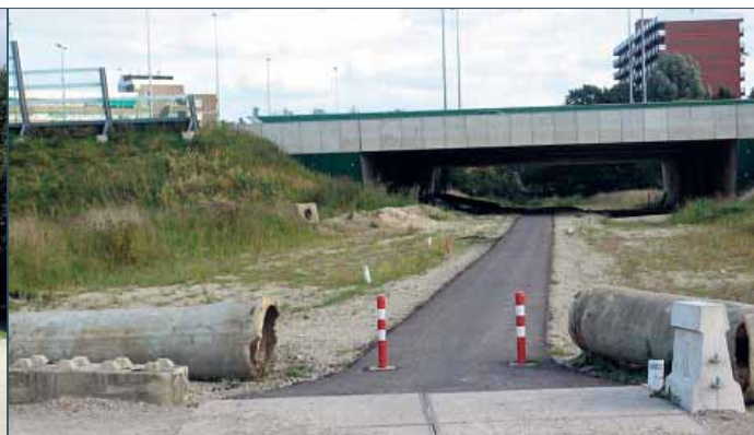
Fietspad vanaf de Heekweg onder de Nieuwe Leeuwarderweg
