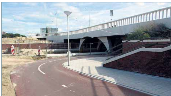
Nieuw fietspad met fietstunnel onder de IJdoornlaan
