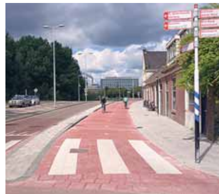
fietspad Velslerweg - Sloterdijk
