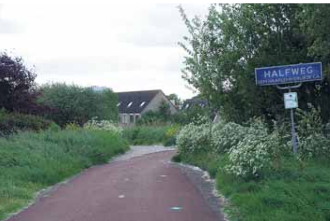
Hinderlijke wegversmalling en zichtversperring
